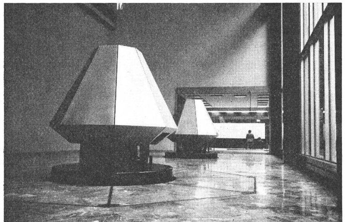
Fig. 1 Zentrale Campocologno I, Maschinenraum
