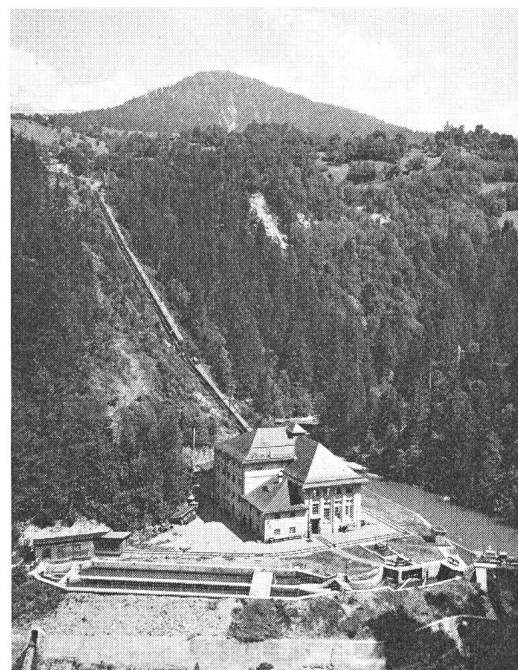
Fig. 4 Zentrale Lüen mit Dufourentsander der Werkstufe Lüen-Chur/Sand
