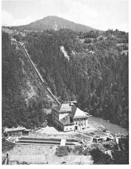
Fig. 4 Zentrale Lüen mit Dufourentsander der Werkstufe Lüen-Chur/Sand
