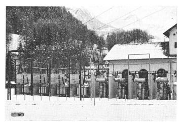
Fig. 11 220/50-kV-Transformatoren im EWZ Albulawerk Sils
