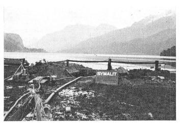
Fig. 14 Bau einer Kabelleitung durch den Silsersee
