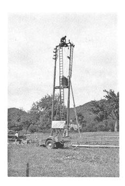
Fig. 7 Bau einer Mast-Transformatoren-Station in Pratyal
