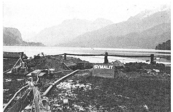
Fig. 14 Bau einer Kabelleitung durch den Silsersee
