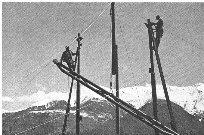
Fig. 8 Bau eines Abspannmastes am Heinzenberg
