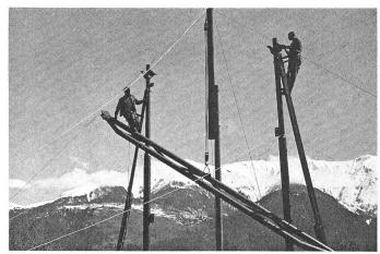
Fig. 8 Bau eines Abspannmastes am Heinzenberg
