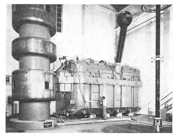
Fig. 2 Drehstrom-Volltransformatoren-Bank  $430 \pm 5 \%/27$  kV, 1140 MVA
