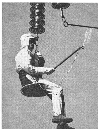
Im Rahmen der von der SERECT (Section d'Etudes, des réalisations et d'expérimentation du Comité des Travaux sous tension) ausgeführten Versuche über die Arbeiten unter sehr hohen Spannungen wurde auch ein leitender Anzug unter 225 kV geprüft.
