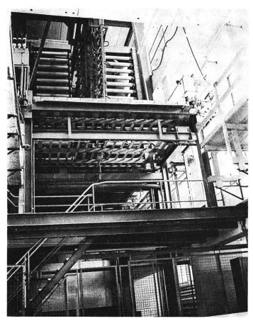
Fig. 5 Anlage zur Herstellung eines verbesserten, heissgepressten Transformerboards
