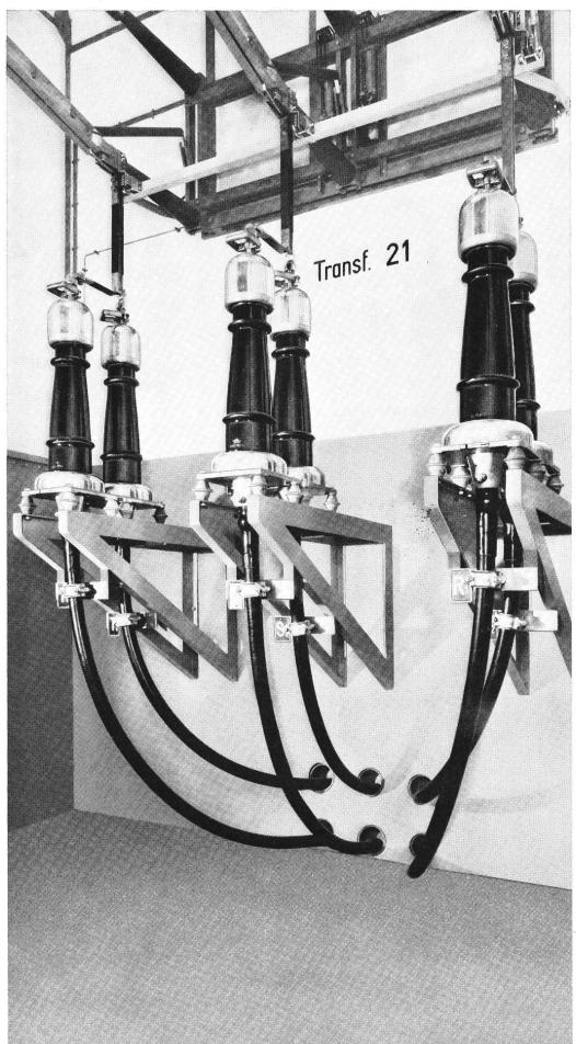
60 kV Einleiter-Oelkabel 1x 800 mm<sup>2</sup> mit Innenraum-Kabelendverschlüssen als Verbindungsleitung zwischen Schaltanlage und Transformator in einem Unterwerk 220/60 kV
