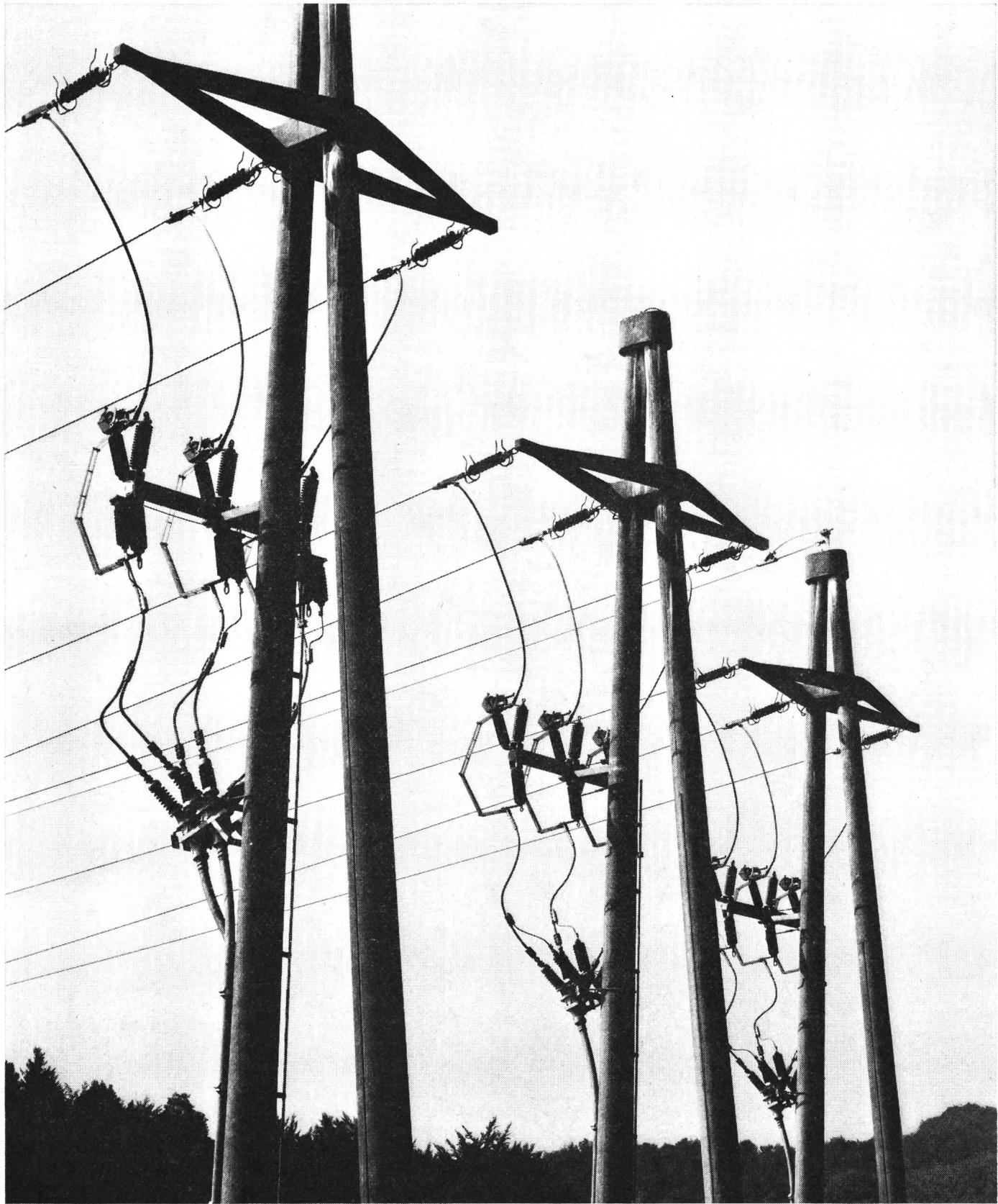
Energietransport ist ein komplexer Vorgang, vergleichbar einem Konzert: alles muss aufeinander abgestimmt sein und technisch fehlerfrei zusammenwirken. Unser Bild: Übergang von 20 kV-Dreileiter-Haftmassekabeln auf 3 Freileitungen unter Verwendung von Dreileiter-Freiluft-Endverschlüssen auf Konsolen mit Überspannungsableitern.
