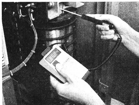
Messung der Oberflächentemperatur mit Technotherm Digital-Thermometer 1500
