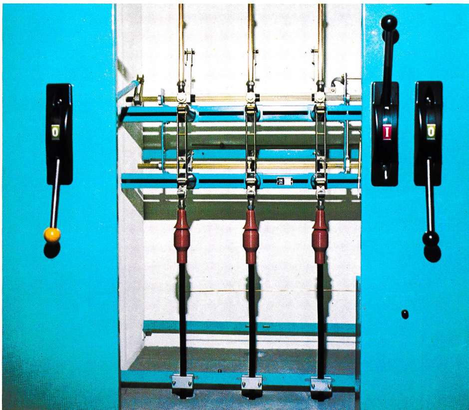
Raumsparender Anschluss einer Schaltzelle mit «ixosil» Innenraum-Endgarnitur, Spannungsreihe 20/11,5 kV.
