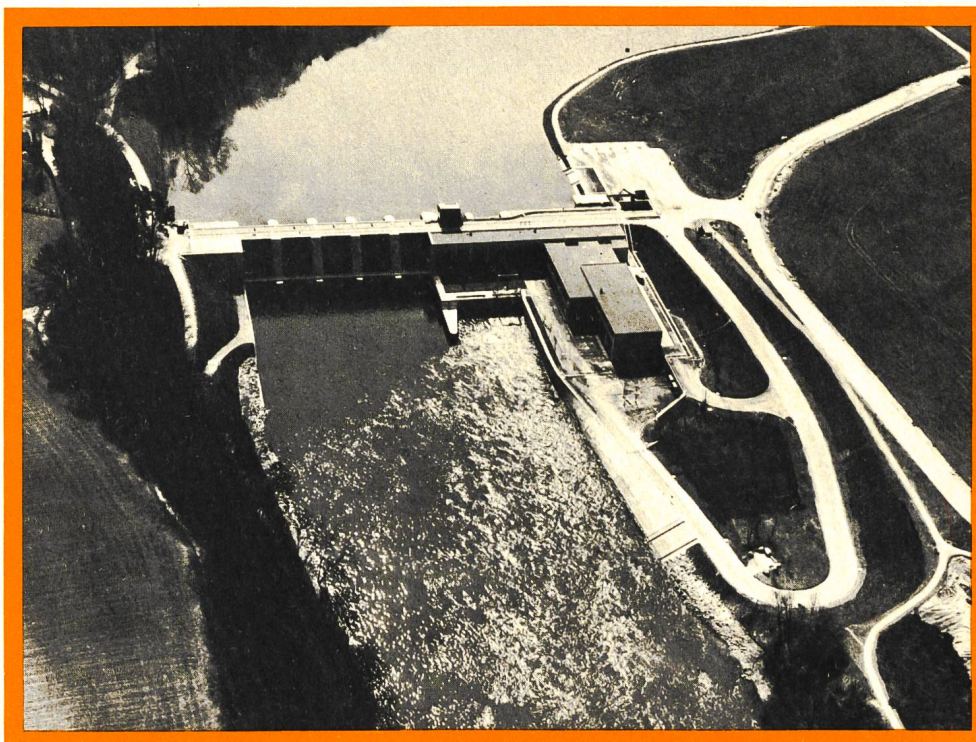
Centrale au fil de l'eau de Bremgarten-Zufikon
