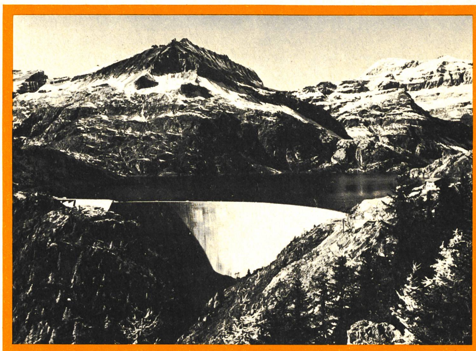
Barrage de l'aménagement hydroélectrique d'Emosson
