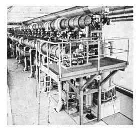
Fig. 1 SF<sub>6</sub>-Schaltanlage des Unterwerkes Katz
