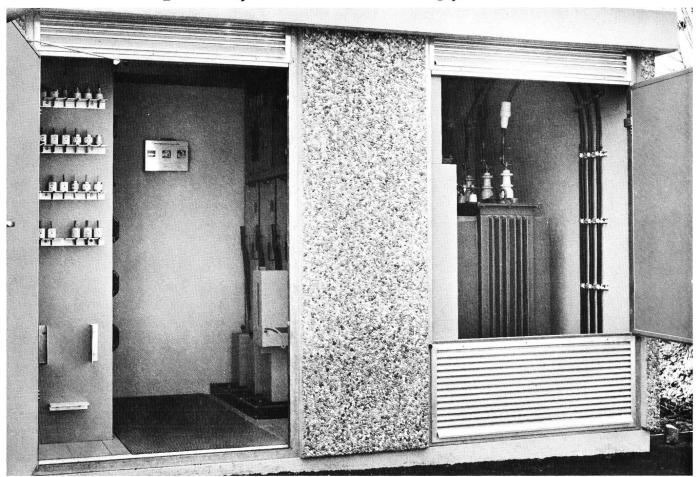
Fabrikfertige, typengeprüfte Kompaktschaltanlage Typ RGB 24 mit ausfahrbaren dreipoligen Lastschaltern 400 A, 24 kV
