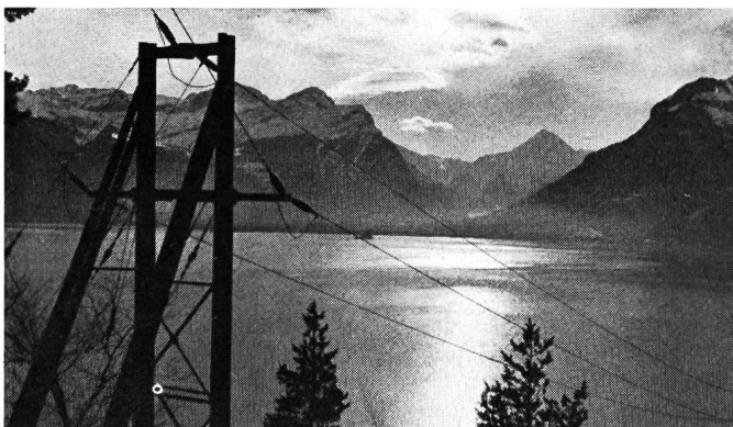
Fig. 1 15-kV-Leitung Seelisberg, Abspanngestänge
