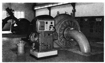
Fig. 2 Zentrale Sahli (ferngesteuert von Kraftwerk Bisisthal) mit den Maschinengruppen Ruosalp im Vordergrund (Francisturbine) und Glattalp (Peltonturbine)
