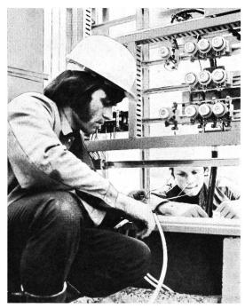
Fig. 3 Installationsmonteure beim Ausrüsten einer Hauptverteilung
