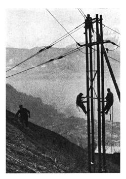
Fig. 1 Verankerung eines Abspanngestänges in steilem Gelände
