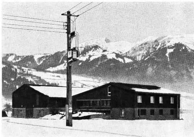
Fig. 5 Einmast-Transformatorstation (Betonmast)
