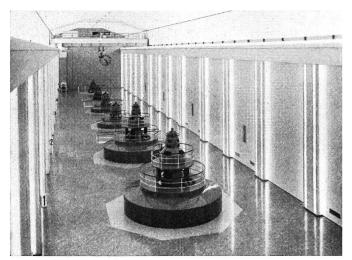
Fig. 5 Maschinensaal mit Generatoren des Kraftwerkes Göschenen
