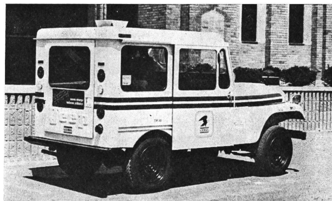
Fig. 1 Kleinlieferwagen der American Motors General Corporation für die US-Postverwaltung Max. Geschwindigkeit: 60 km/h Reichweite pro Batterieladung: mindestens 50 km
