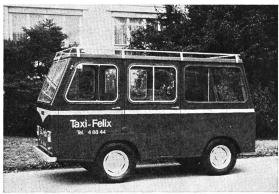
schen. Die 48-V/280-Ah-Traktionsbatterien von 700 kg machen rund die Hälfte des gesamten Fahrzeuggewichtes aus. Eine einfache Vorrichtung erlaubt es, die leeren Batterien relativ rasch gegen geladene auszutauschen. Das Elektrofahrzeug wird von 2 48-V-Seriemotoren von je 4 kW Nennleistung angetrieben, die über Thyristoren stufenlos gespeist werden. Es fährt sich wie ein gewöhnlicher Personenwagen mit automatischem Getriebe, wobei aber mit dem «Gaspedal» die Fahrgeschwindigkeit vorgegeben wird.
