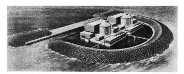
Fig. 1 Modell des im Küstengewässer verankerten Kernkraftwerkes
