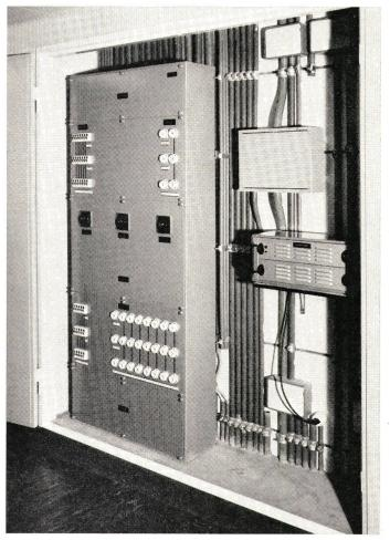
Fig. 2 Stockwerkverteiltableau mit Hauptschaltern, Leitungsschutzschaltern und Schmelzsicherungen
