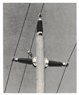
Fig. 2 16-kV-Freileitung mit Stützisolatoren
