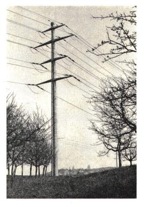
Kombinierte Freileitung mit zwei Drehstromsystemen 50 kV und zwei 132-kV-Einphasenschlaufen
