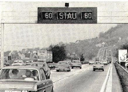
schaltet, damit sich die Kraftfahrer auf die veränderte Verkehrslage rechtzeitig einstellen können. Die Stauwarnanlage wird zentral von einem *Siemens*-Verkehrsrechner VSR 16030 gesteuert, der in der Autobahnzentrale Kirchheim/Teck aufgestellt ist. Hier werden die Informationen ausgewertet, die von den in die Strassendecke eingebauten Induktionsschleifen kommen, und je nach Verkehrslage Befehle für die Anzeigegeräte auf den Signalbrücken erarbeitet.
