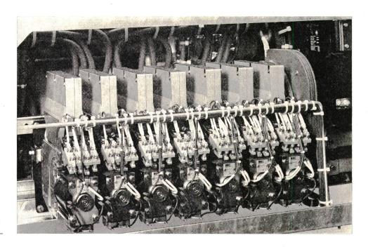
Fig. 9 Batterie elektromagnetischer Bahnschütze
