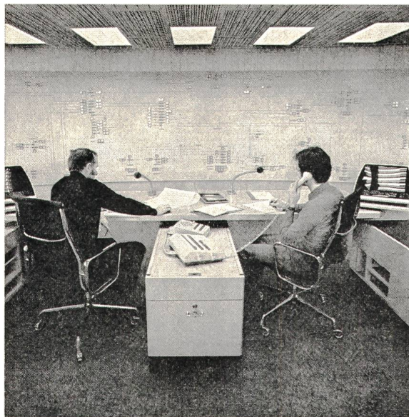
Fig. 4 Ansicht des Kommandoraumes mit Blindschaltschema
