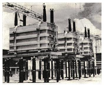
Fig. 3 Umrichterstation einer HGÜ-Anlage
