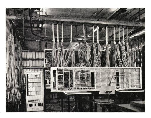
Fig. 2 Verdrahtungsprüfgerät VERAM
