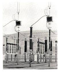
Trägerfrequenz-Übertragung über die werkeigenen Hochspannungsleitungen mit den bewährten BBC-TFH-Geräten
