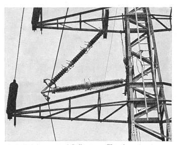
Fig. 1 Freileitungsmast mit Isoliertraverse (Versuchsanordnung)
