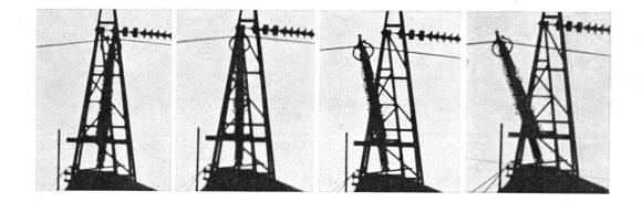
Fig. 6 Bewegung der Isoliertraverse nach erfolgtem Lastabwurf
