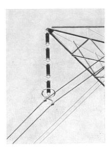
Fig. 1 380-kV-Bündelleiter mit klassischen Langstabisolatoren und Lichtbogen-Schutzarmaturen
