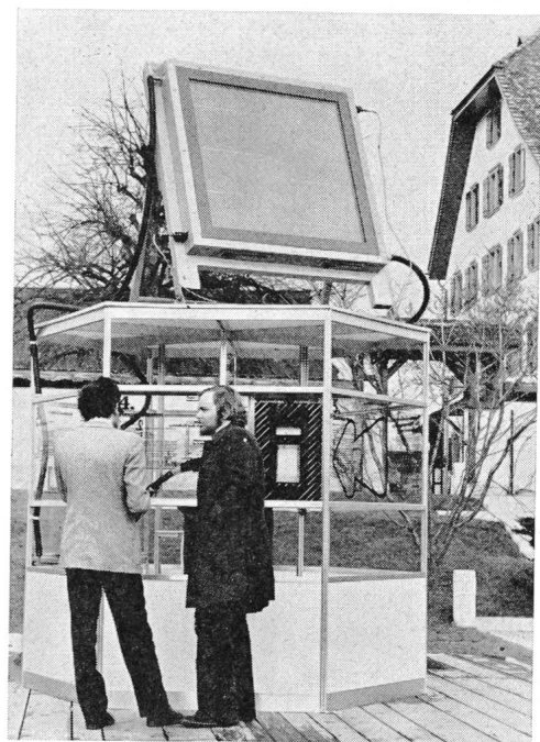
Fig. 1 Demonstrationsmodell eines Sonnenwärme-Kollektors
