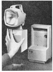
der Ladevorgang. Bei Stromausfall wird das Licht des Handscheinwerfers automatisch eingeschaltet. Als Stromquelle dient eine Ni-Cd-Batterie, deren Lebensdauer so gross ist, dass etwa 2000 Ladungen möglich sind.
