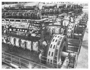
Für den Einbau der drei neuen Gruppen muss die Dieselzentrale entsprechend verlängert werden. Sie wird mit einer Gesamtleistung von 100 000 kW die grösste Dieselzentrale der Welt sein. Die Bestellung umfasst ausser den Hauptmotoren die gesamten Anlageteile, wie Kühlwasserpumpen, Brennstoff- und Ölpumpen, Brennstoffaufbereitung, Vorratshaltung, Wasseraufbereitung, Abgaswärmeverwertung und Feuerlöschanlage.
