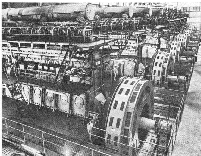
Für den Einbau der drei neuen Gruppen muss die Dieselzentrale entsprechend verlängert werden. Sie wird mit einer Gesamtleistung von 100 000 kW die grösste Dieselzentrale der Welt sein. Die Bestellung umfasst außer den Hauptmotoren die gesamten Anlageteile, wie Kühlwasserpumpen, Brennstoff- und Ölpumpen, Brennstoffaufbereitung, Vorratshaltung, Wasseraufbereitung, Abgaswärmeverwertung und Feuerlöschanlage.
