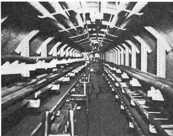
Fig. 2 165-kV-Kabel in einem Mehrzweckschacht
