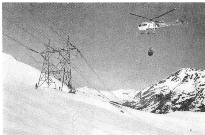
Fig. 3 Leitungsreparatur in den Alpen
