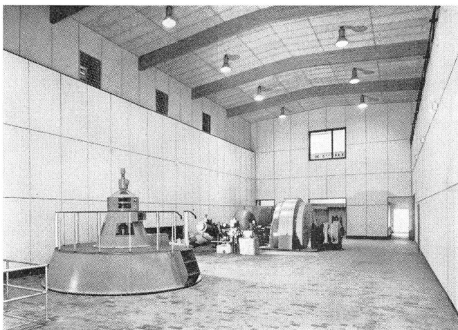
Fig. 4 Intérieur de la centrale de Morobbia (au premier plan le nouveau groupe de 10 MW)
