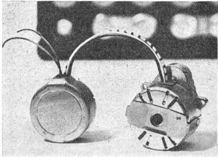
Synchronmotor benötigte Impulsform um. Die Kombination AMY81 mit Wechselrichter ergibt einen Motor, dessen Drehzahl von der Belastung unabhängig ist. Weil sich hier kein Kollektor abnutzen kann, wird eine hohe Lebensdauer und absolute Funkenstörfreiheit erzielt.
