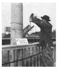
**TEROLIN-**Lack schwarz, als Stockschutz über Copra-Impfung, Anstrich für Druckleitungsrohre, Schieberanlagen. Bei Gittermasten erstklassiger Betonsockelanstrich.
