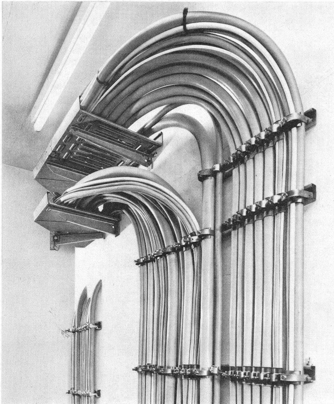
Beispiel aus der Praxis: Die Versorgung eines Hochhauses wurde mit Mehrleiter-Kunststoffkabeln gelöst. Hier zeigen wir die Kabelsteigleitungen.
