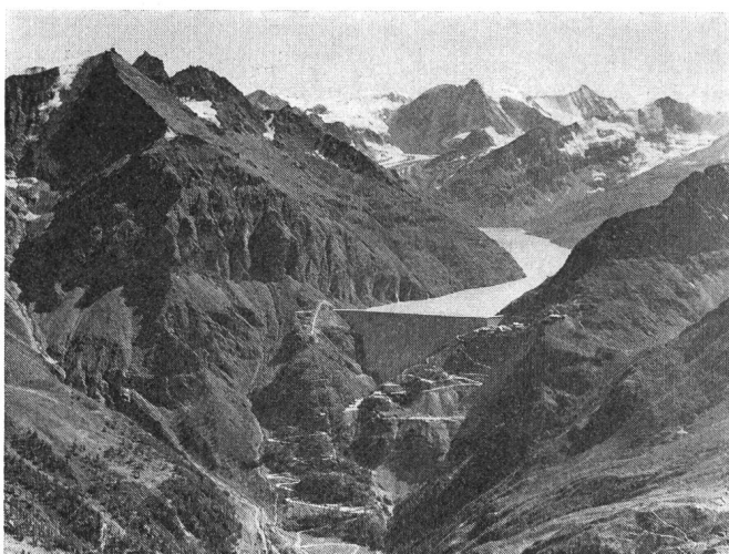
Fig. 1 Le barrage de Grande Dixence en Valais (hauteur 284 m, retenu: 400 millions de m 3 )
