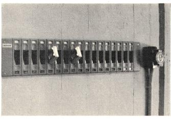
Fig. 11 Fächerzeile zum Aufladen der Personensuch-Empfänger
