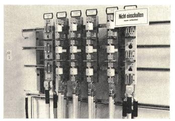
Fig. 2 Sekundärverteilung in der Transformatorstation
