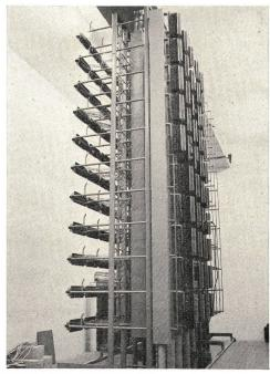
Fig. 9 Telefon-Hauptverteiler
