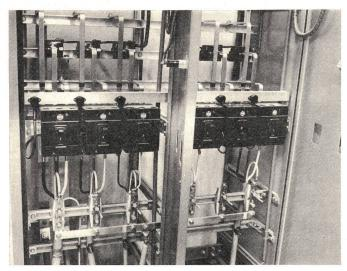
Fig. 3 Einbau und Anschluss von Abgangs-Automaten in der Sekundär-Hauptverteilung
