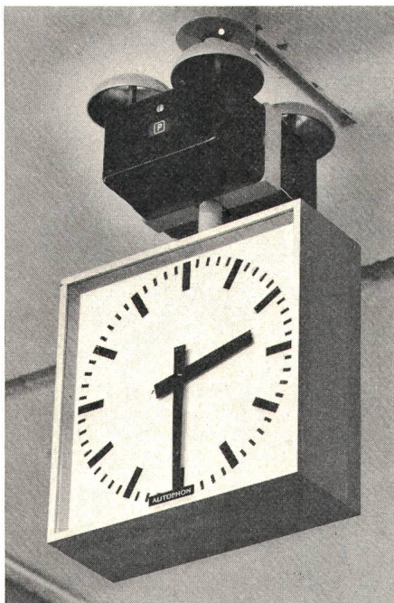
Fig. 10 Doppelnebenuhr und Arbeitszeitsignal an Deckenpendel
