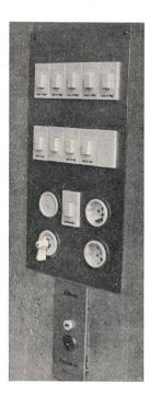
Fig. 5 Norm-Schaltplatte für die Bedienung der Beleuchtung
