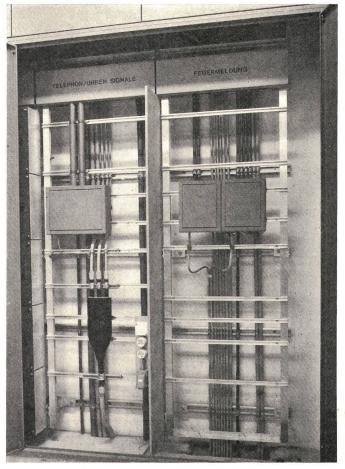
Fig. 4 Etagenverteiler Schwachstromseite
