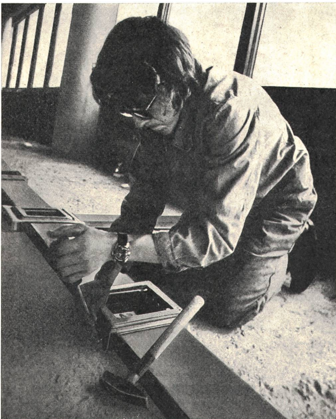
Fig. 10 Montage des Unterflur-Bodenkanalsystems
