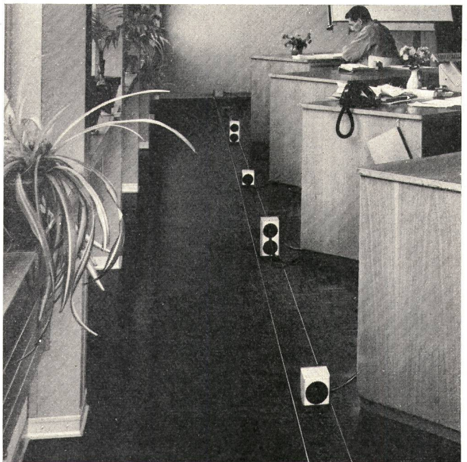
Fig. 7 Überflur-Bodenkanal (abdeckbar), mit montierten Anschlussaufsätzen
