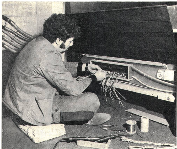
Fig. 3 Telefonmonteur beim Anschliessen eines Brüstungs-Zwischenverteilers
