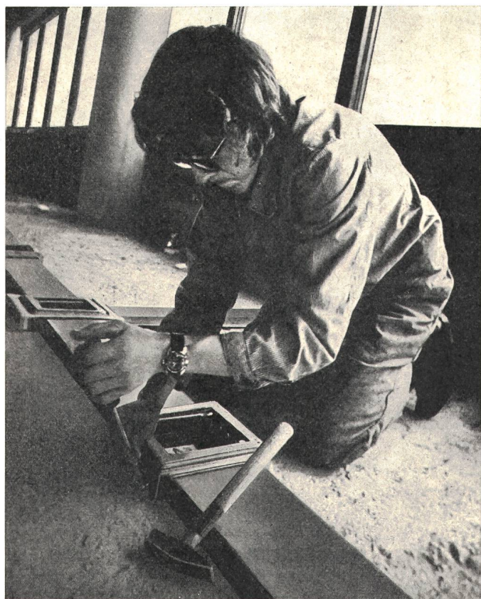
Fig. 10 Montage des Unterflur-Bodenkanalsystems
