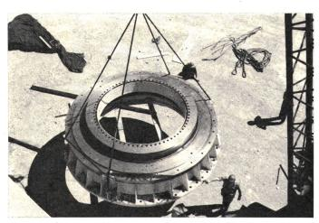
Fig. 3 Hochheben des Azimutlagers und Auflagers
