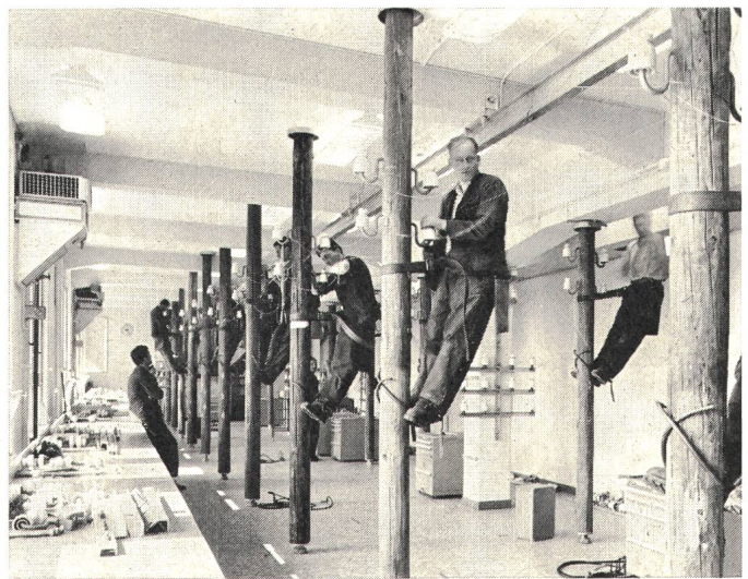
Fig. 5 Werkstatt für Zentralkurse mit Freileitern an der Arbeit
