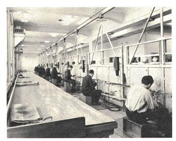
Fig. 3 Werkstatt für Zentralkurse, eingerichtet für die Ausbildung von Kabelspleissern. Spleisswände in nebeneinanderliegender Anordnung zur Anfertigung einer durchgehenden Kabelanlage
