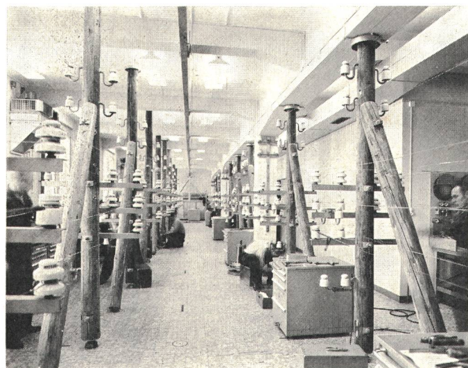
Fig. 4 Werkstatt für Zentralkurse, eingerichtet für die Ausbildung von Leuten des oberirdischen Linienbaues. Die Spleisswände sind an eine Rückwand des Raumes verschoben
