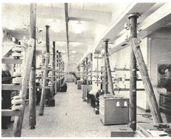
Fig. 4 Werkstatt für Zentralkurse, eingerichtet für die Ausbildung von Leuten des oberirdischen Linienbaues. Die Spleisswände sind an eine Rückwand des Raumes verschoben
