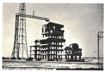
Fig. 2 2,25-MV-Kaskade im Hochspannungs-Forschungszentrum der Egyptian Electricity Corporation
