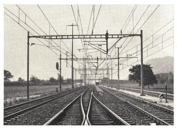
Fig. 9 R-Fl einer Station. Hängestützen mit Auslegern
