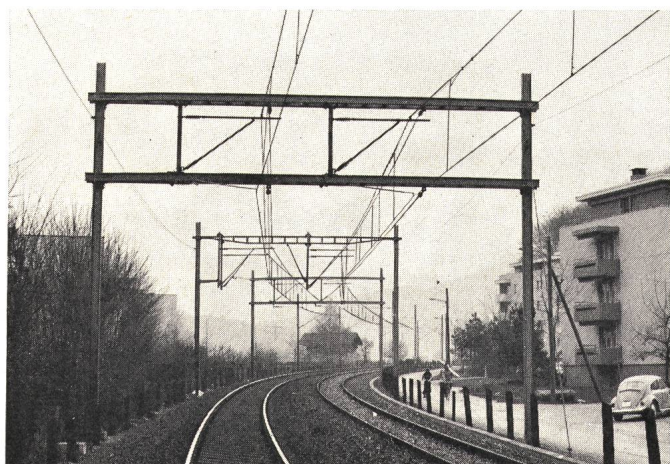
Fig. 8 2feldrige Nachspannung (entsprechend Fig. 7)
