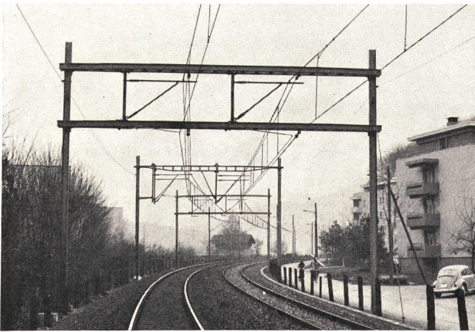
Fig. 8 2feldrige Nachspannung (entsprechend Fig. 7)
