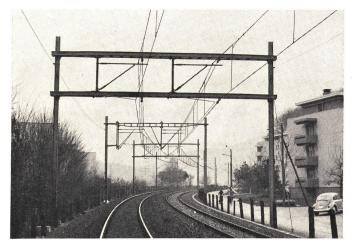
Fig. 8 2feldrige Nachspannung (entsprechend Fig. 7)
