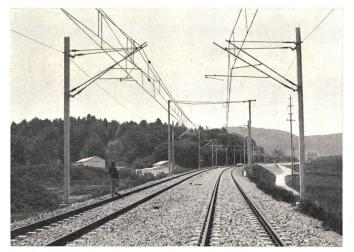
Fig. 6 3feldrige Streckentrennung (entsprechend Fig. 5)
