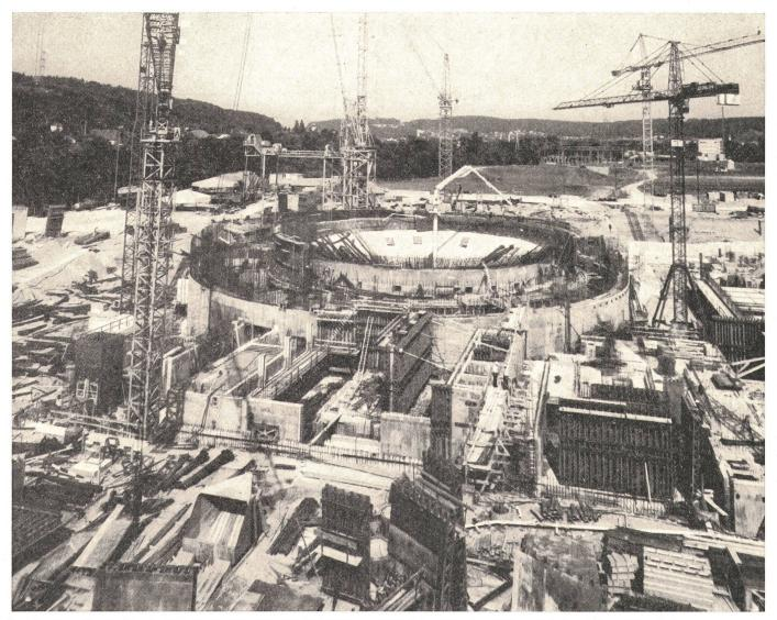
Fig. 8 Baustelle des Kernkraftwerks; Im Vordergrund das Hilfsanlagengebäude, dann das Reaktorgebäude mit dem 130 m hohen
