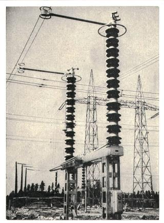
Trennschalter 420 kV, 1600 A mit Motorantrieb und Erdungstrenner Sectionneur 420 kV, 1600 A avec commande à moteur
