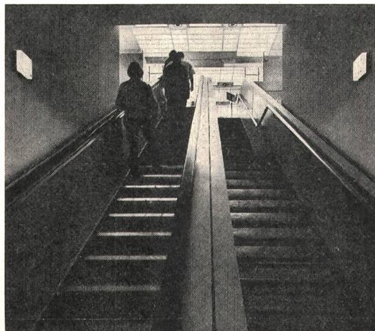
An dieser Rolltreppe eines Flughafens arbeiten FRIWO-Sicherheitsleuchten Typ 15568 in Bereitschaftsschaltung. Bei Netzausfall schalten sie sich automatisch ein und liefern bis zu 3 Stunden Licht zur Sicherheit aus den eingebauten NC-Akkus.
