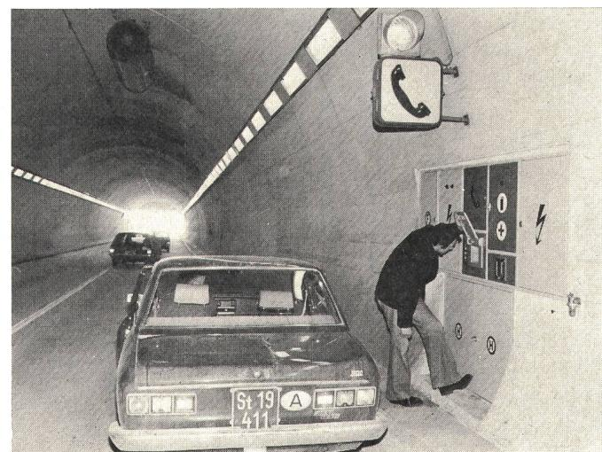
«Feuerwehr» zu drücken; ohne Sprach- oder Verständigungsschwierigkeiten ruft er damit die zuständige Stelle zu Hilfe. Sein Tastendruck löst auch «Achtung» bei der Einfahrt aus, die noch im Tunnel fahrenden Autos werden durch gelb blinkendes Licht gewarnt.
