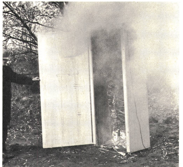
Nach Öffnen des Schaltschranks Entflammung der Kunststoffisolation infolge Sauerstoffzufuhr. Lösversuche mit Halon, CO 2 und ABC-Staub Ouverture de la porte de l'armoire. Allumage de l'isolation synthétique par l'accès d'oxygène. Essai d'extinction avec Halogène, poudre ABC et CO 2
