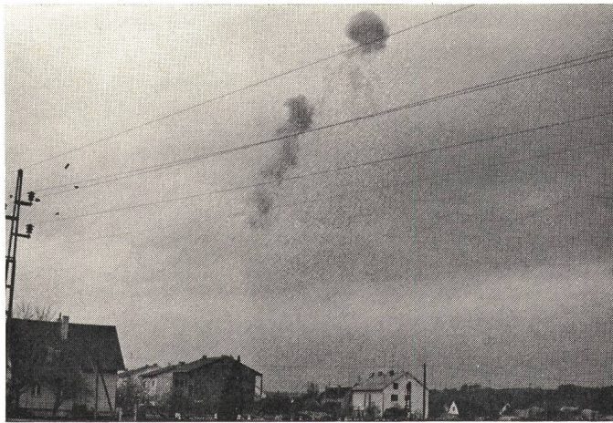
Fig. 6 Typischer Funkenregen, herrührend von Werkstoffabtragungen an den Kupfer-Leiterseilen im Wege eines bewusst bei einer Wurf-Prüferdung herbeigeführten Kurzschlusses auf einer 45-kV-Leitung.
