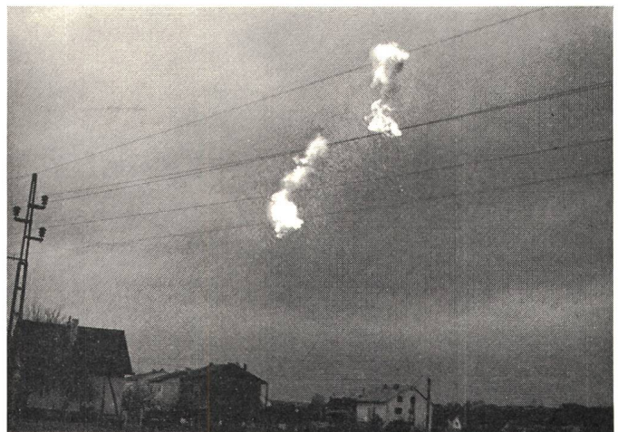
Fig. 5 Lichtwirkungen eines über eine Metallitze eingeleiteten, frei brennenden Kurzschluss-Lichtbogens gemäss Fig. 4; nach einer Zeit von 440 ms bereits weitgehend abgeebbt.
