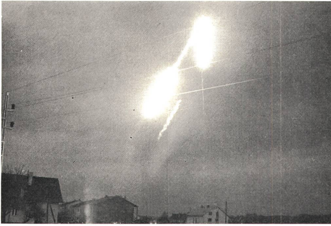
Fig. 4 Galvanischer Kurzschluss über zwei Netzaussenleiter (Phasen) einer 45-kV-Leitung, mit mehrfacher Erdbeteiligung, aufgenommen mit einer federwerkbetriebenen Kleinbildkamera höherer sekundlicher Einzelbildfolge (Motor-Leica).
